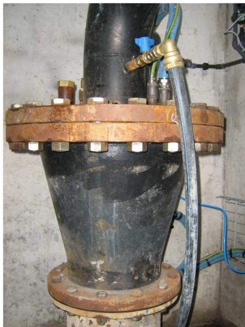
Sambuque : Cône de sortie de forage permettant le passage des câbles et sondes.
