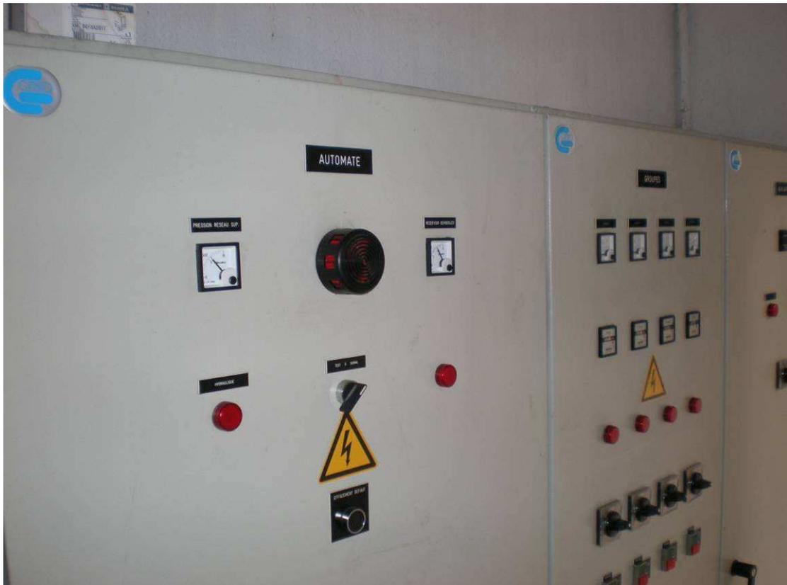
Semboules : renouvellement de 6 afficheurs de l'armoire électrique
