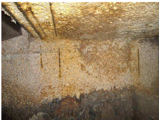
Fosse amont décapée (le béton a été attaqué en partie haute jusqu'à mise à nu des bétons)
