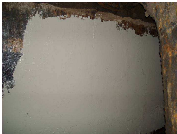
Bâche d'eau de lavage étanchée
