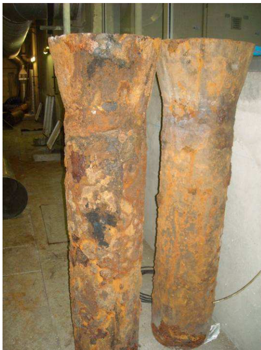
Canalisations de sortie des « BIOCARBONE » très abîmées
