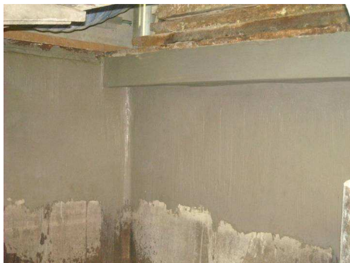
Fosse amont après travaux
