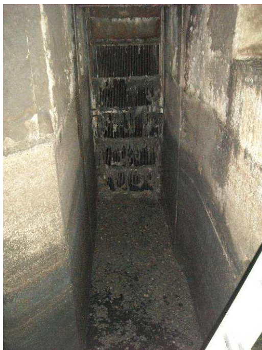
Dégrilleur grossier avant nettoyage
