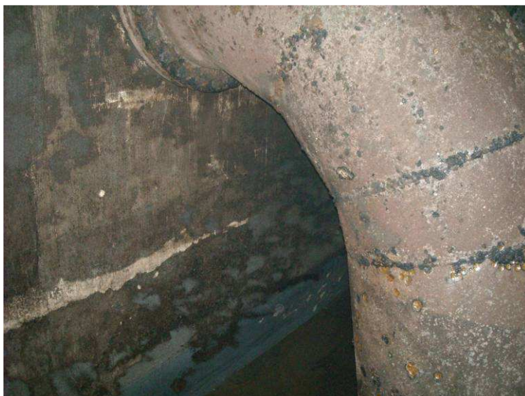
Fuite de la bâche d'eau de lavage
