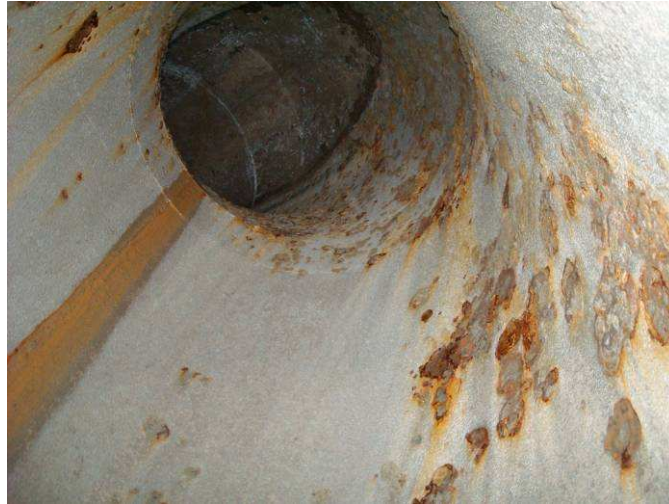
Canalisation eau traitée intérieure
