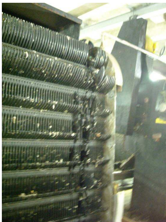
Dégrilleur fin abîmé
