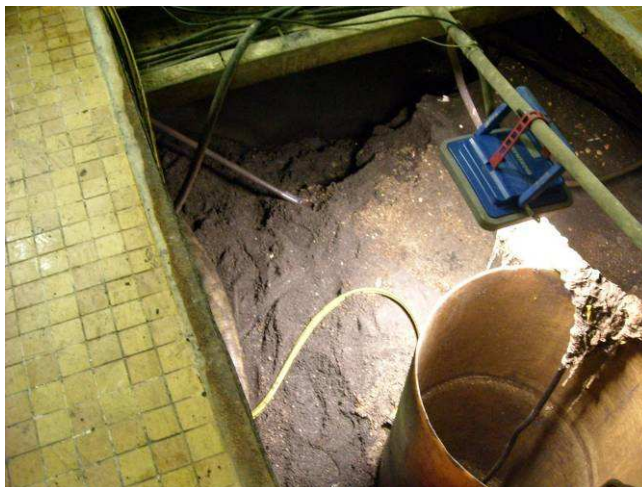
Fosse amont pleine de sable
