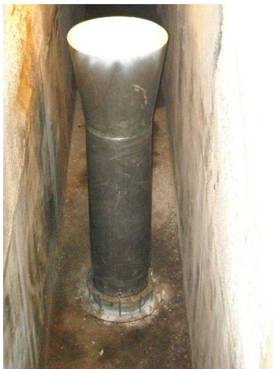
Tulipe neuve installée
