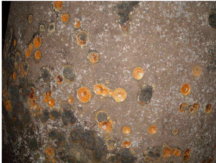
Canalisation eau traitée extérieure
