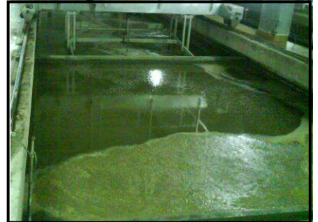
Etape de dessablage / déshuilage
