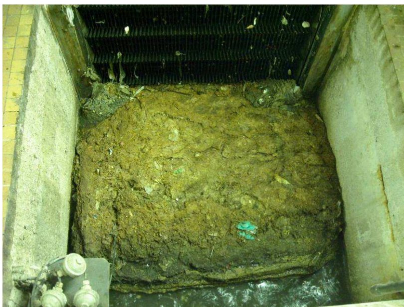
Accumulation de graisses en amont du dégrilleur
