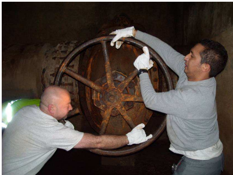
Ouverture de la vanne de by-pass
