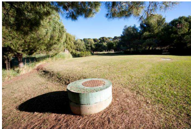
Vue du toit de la station d'épuration
