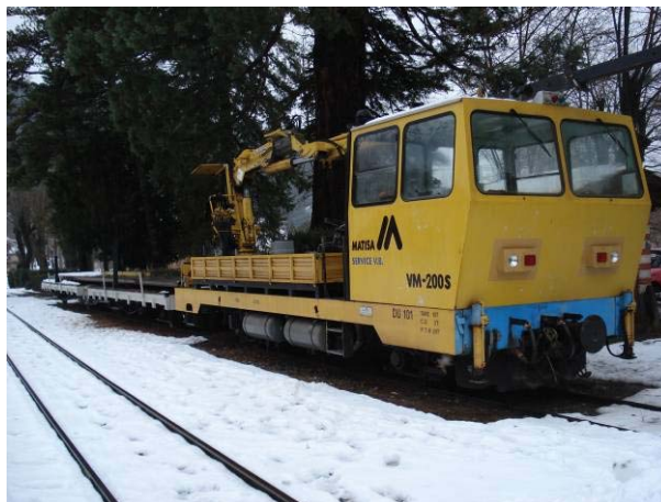
Préparation des travaux de voies prévus en 2009 (approvisionnement en rail des zones de chantier)
