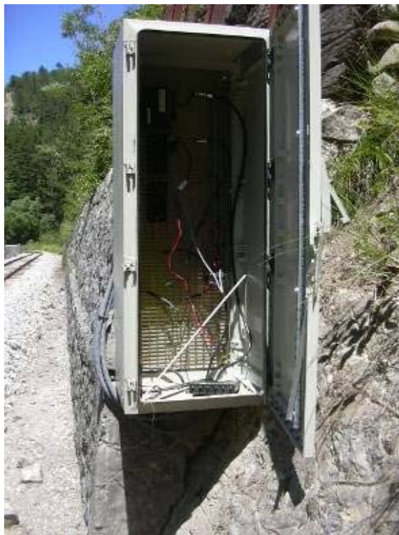
Armoire Radio du Tunnel de Serre-Geneston
