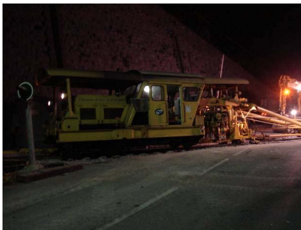
21 octobre 2008 : opération de nivellement, bourrage, dressage au PN de la Chapelle (Entrevaux).
