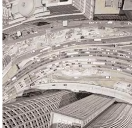
Avant (ci-dessus) et après (à gauche) : enfouissement de l'autoroute et aménagement d'un jardin en couverture dans le centre des affaires de Boston.
