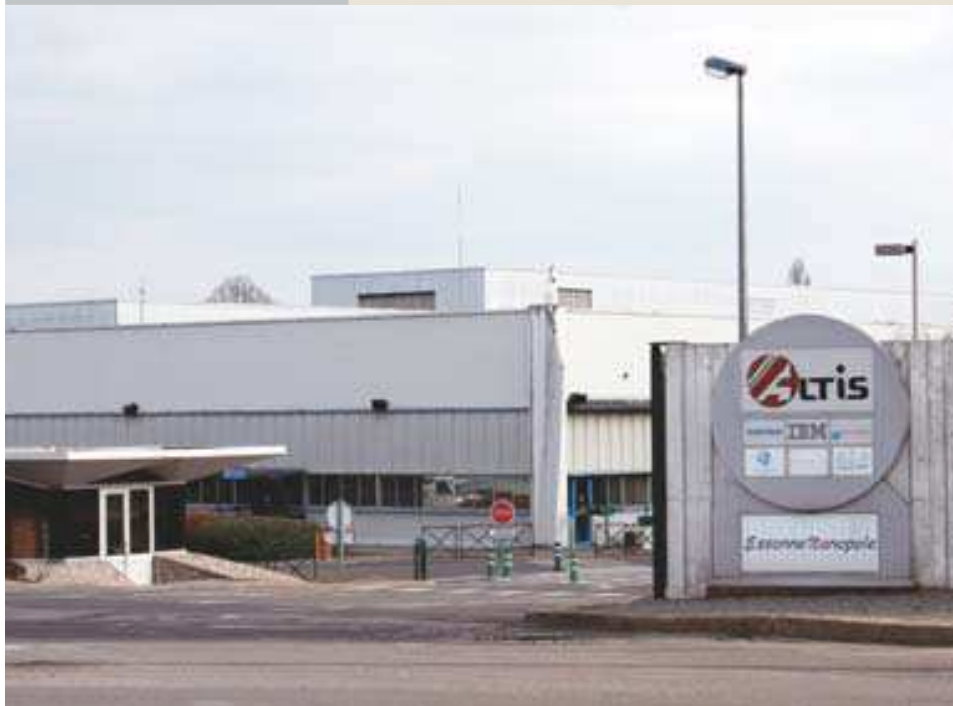
L'usine de semi-conducteurs d'Altis, à cheval sur Corbeil-Essonnes et Le Coudray (91).
