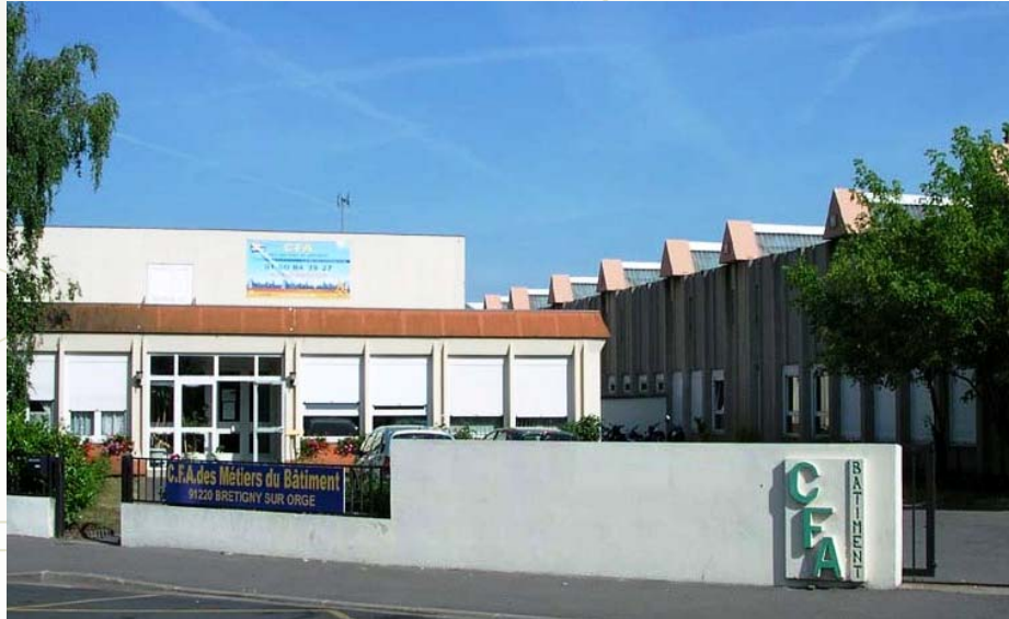
Entrée du C.F.A. de Brétigny sur Orge
