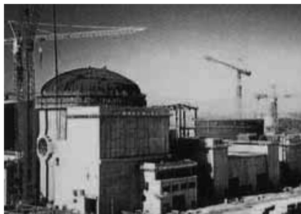
Centrale nucléaire en construction, Chine.
