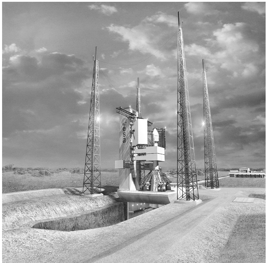
Le chantier pour la construction du pas de tir pour les Soyouz en Guyane a été officiellement ouvert au début du mois d'avril .
