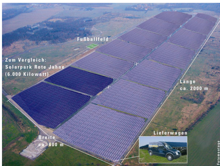
Champ de modules du parc solaire Waldpolenz (40 MW)
