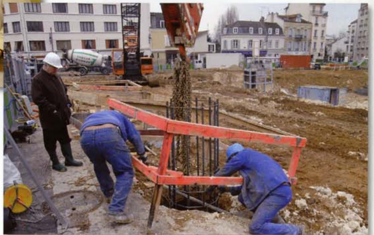
Ci-dessous : le chantier, mi-décembre, avec sa cinquantaine de pieux déjà forés.
