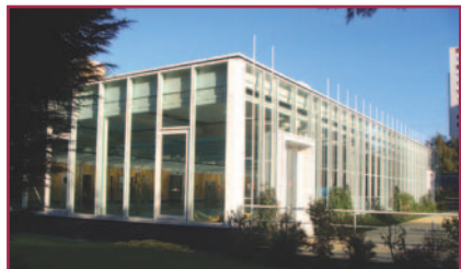
Réhabilitation de la piscine (Montigny) : 420 960 €*
