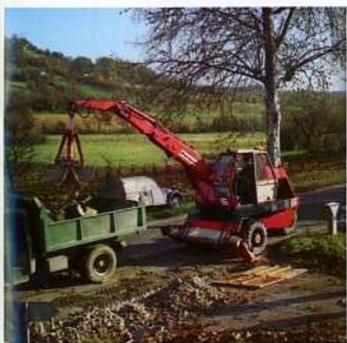
L'exécution d'une tranchée déportée avec la benne sur cette route nationale n'entrave pas la circulation.
