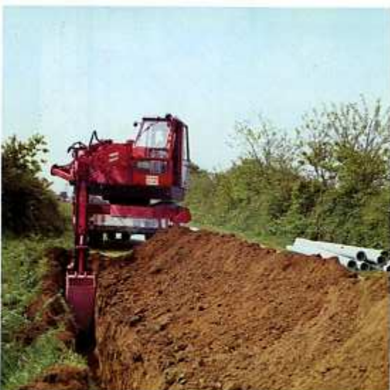
L'exécution de cette tranchée de canalisation sur une vicinale bordée de clôtures et de haies nécessite l'utilisation du rétro déporté avec le godet 0,50 m.
