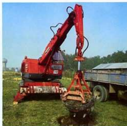
Forage d'un puits en terrain meuble par la benne cylindrique de diamètre 1,20 m.
