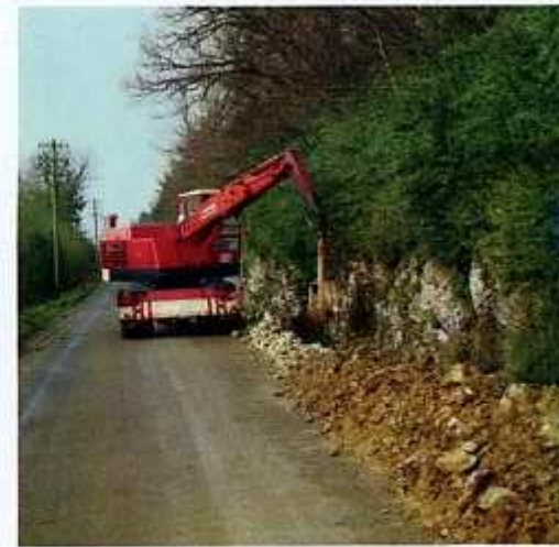
Utilisation de la benne pour l'ouverture d'une tranchée déportée, à flanc de paroi, sur une route de montagne.
