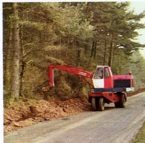
La lame de remblayage montée en rétro permet de travailler près de la tranchée et d'y ramener les déblais du bord opposé.
