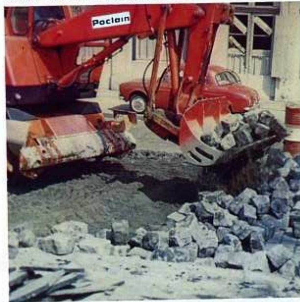
Dépavage dans le Nord avec le chargeur claire-voie.
