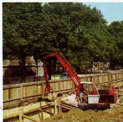
Sur une artère parisienne : fouille profonde entre boisages. Le bâti long peut descendre à 7,50 m.
