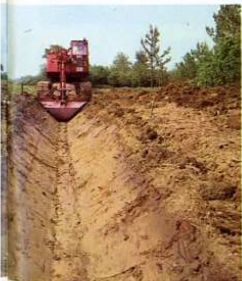
Remembrement en Bretagne : des kilomètres de fossés bien "finis" avec le trapézoïdal 0,35 m.
