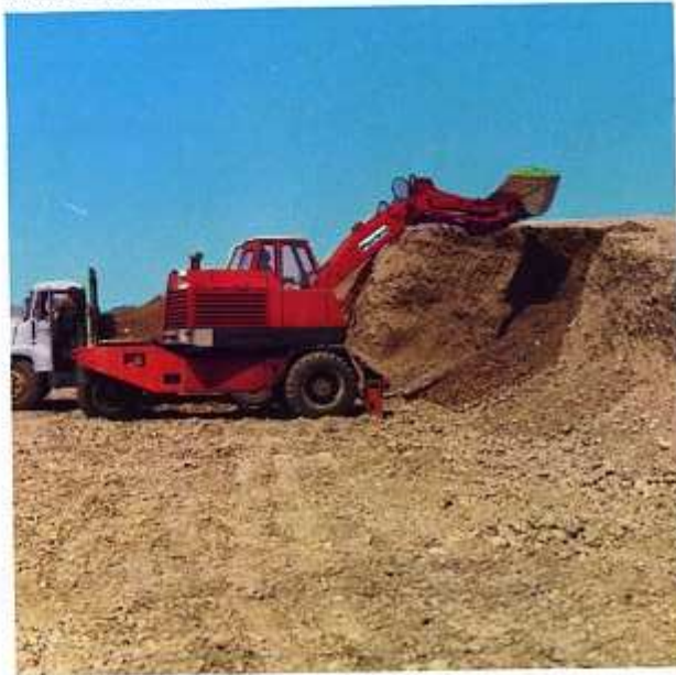
Reprise au tas et chargement sur camion avec le chargeur 500 l.
