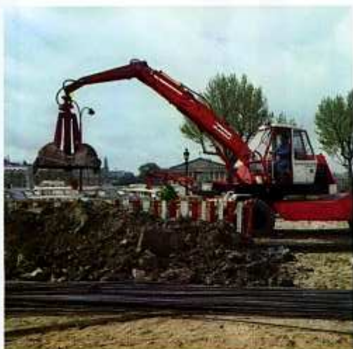
Travaux de terrassement avec la benne 250 l, place de la Concorde à Paris.
