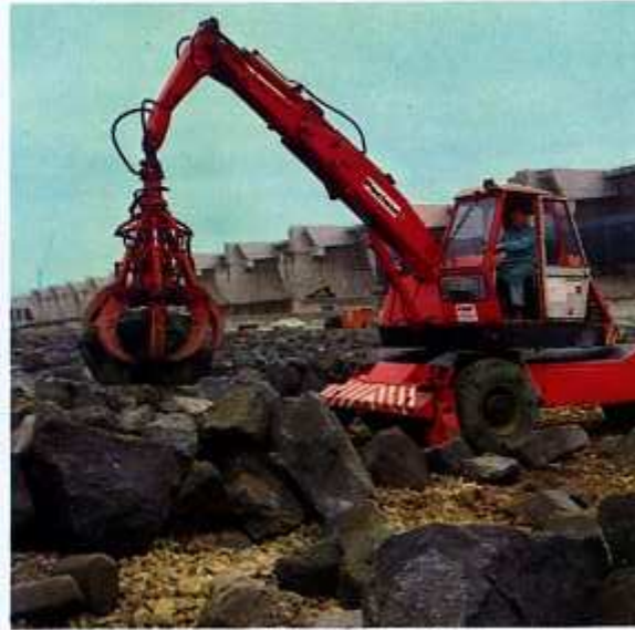
Constitution d'une digue sur la mer en Hollande : déchargement et mise en place précise des blocs de basalte avec la benne 6 griffes.
