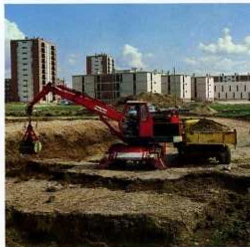
Aménagements d'une cité H.L.M. : terrassements légers avec la benne 400 l et chargement sur camion.
