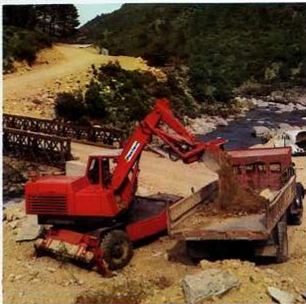
Terrassements durs avec le chargeur niveleur 400 l.
