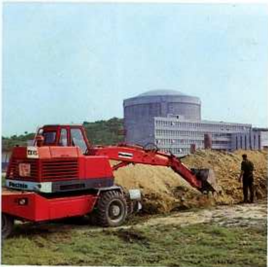
Ouverture d'une tranchée large et profonde dans l'axe de la machine avec le rétro 0,85 m.
