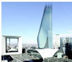
Green Building à la Défense en 2009 Présentée comme un modèle du genre, dotée d'éoliennes en son sommet ou d'une double peau permettant de réguler les apports de chaleur.
