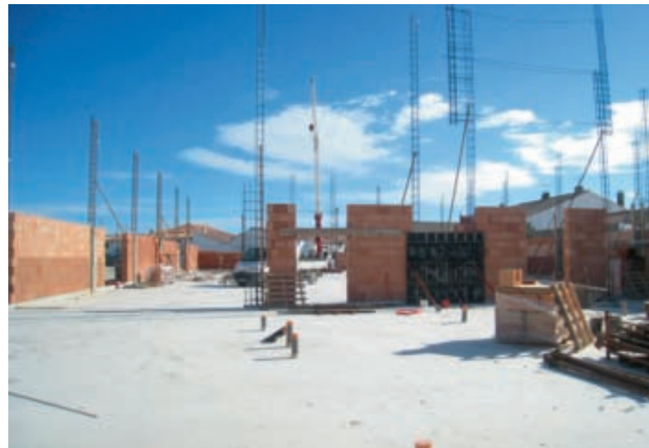
Les premiers murs s'élèvent
