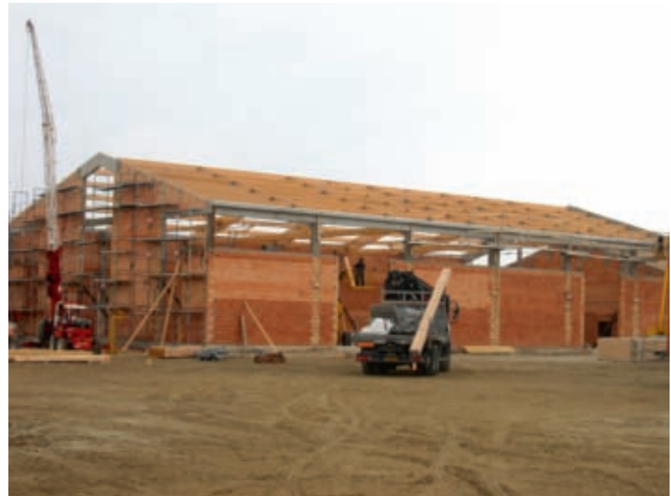
Montage de la charpente
