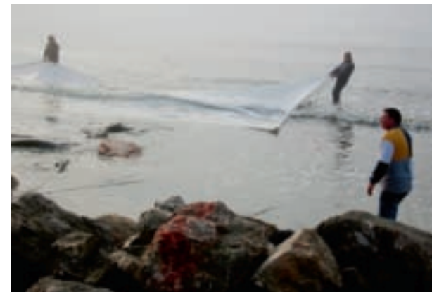
Pose du géotextile pour une meilleure assise de l'enrochement
