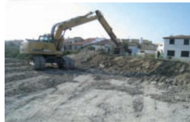
Digue de protection de la zone urbanisée
