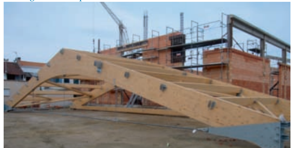
Elément de la charpente
