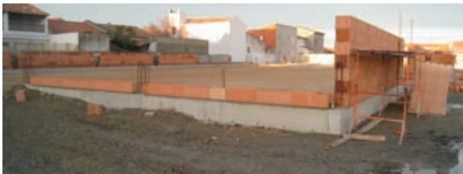
Dalle du complexe
