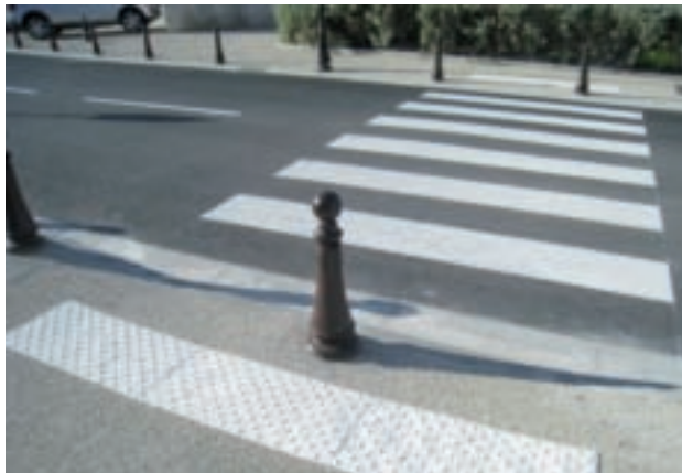
Passage piétons pour mal-voyants
