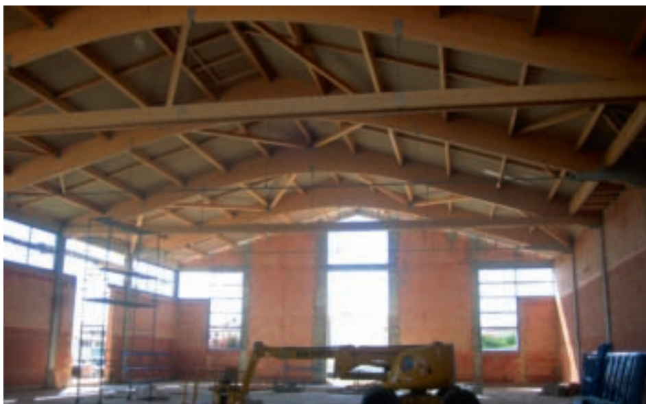
Vue intérieure : la grande salle
