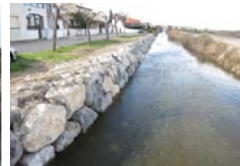
Confortement des berges de la roubine de la barrachine
