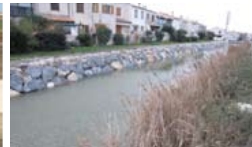
Confortement des berges de la roubine de la barrachine
