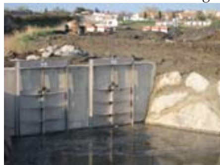
Confortement des berges de la roubine de la barrachine
