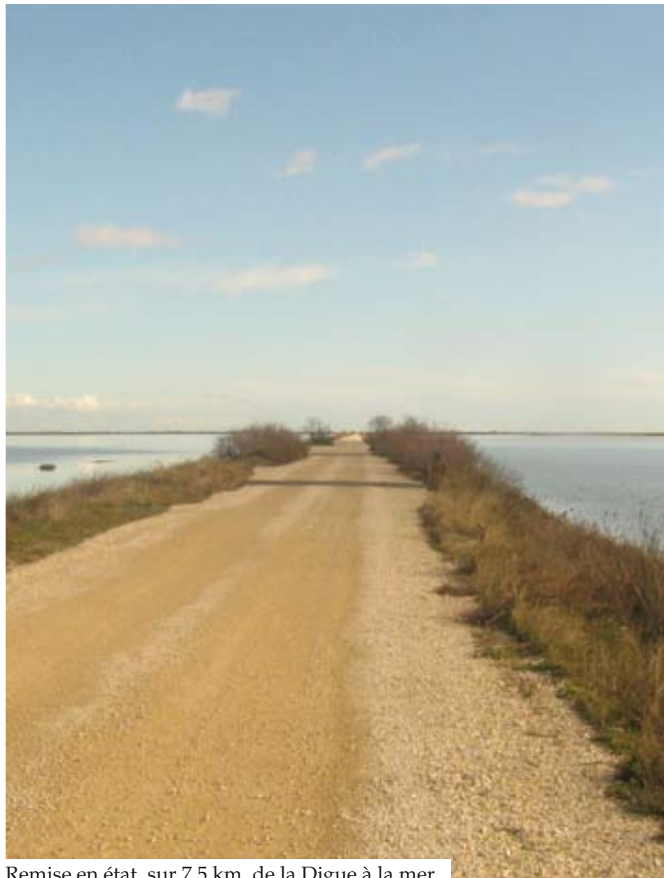
Remise en état, sur 7,5 km, de la Digue à la mer
