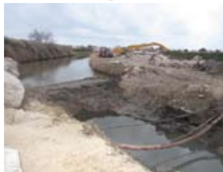
Confortement des berges de la roubine de la barrachine
