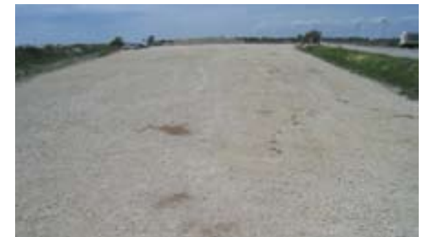
Réfection et agrandissement du parking de la plage du « Clos du Rhône »
