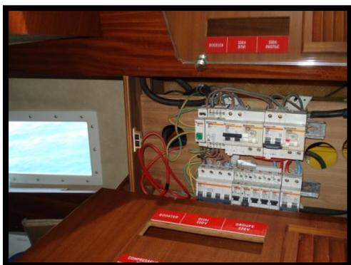
Je démonte du tableau électrique et vérifie toutes les parties du circuit au voltmètre ; idem pour le câble d'alimentation : rien de bizarre si ce n'est qu'il n'y a plus de courant.
