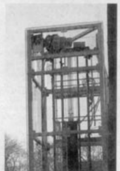
Un des ascenseurs en travaux.
