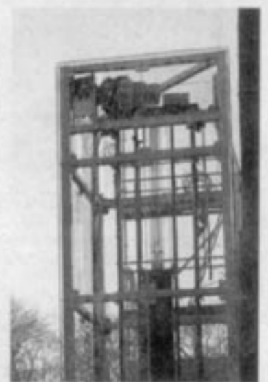
Un des ascenseurs en travaux.
