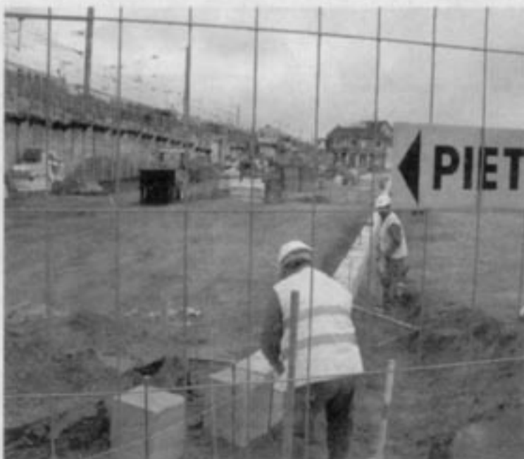
Les travaux à Ermont.
