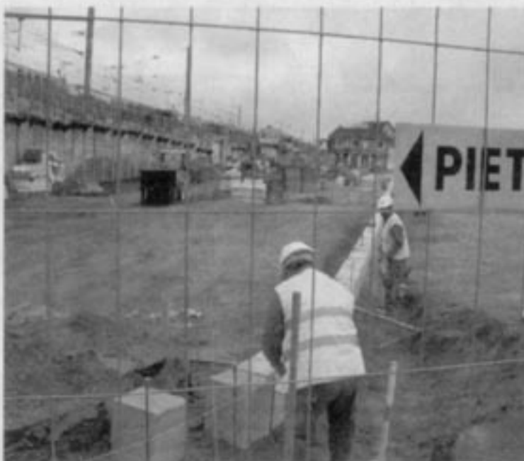
Les travaux à Ermont.
