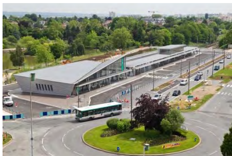
Pôle multimodal de Noisy-le-Grand
