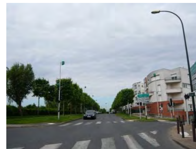
Front bâti - Rue du Marnois
