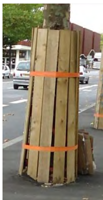
Exemple de protection physique d'un arbre existant
