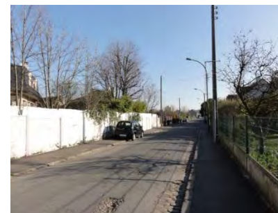
Pavillons en cours de démolition au Sud du périmètre, le long de la rue Jules Ferry
