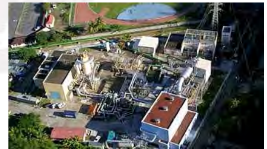
Géothermie « haute énergie » Centrale de Bouillante (Guadeloupe)
