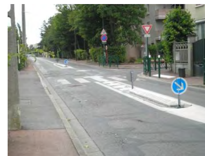
Traversée piétonne conforme – Rue de Malnoue à hauteur de la rue Fajol
