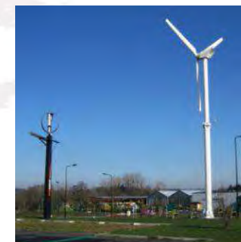
Deux types d'éoliennes à axe horizontal et vertical- Combourg (35)
