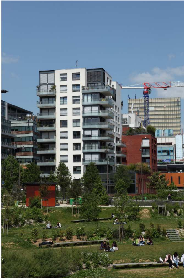
UN IMMEUBLE HAUT OUVERT SUR UN PARC PARIS - ZAC MASSENA - DEVILLERS ARCHITECTE
