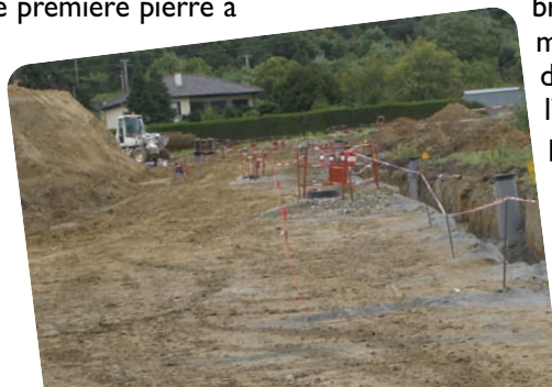
Visite des travaux par les élus
