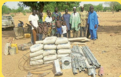
(Matériel pour réparation d'un forage)
