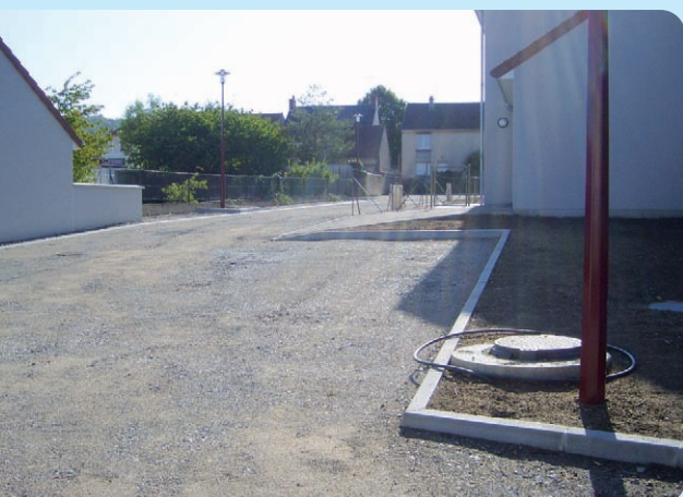
Voirie en cours du lotissement Geneviève Anthonioz de Gaulle
