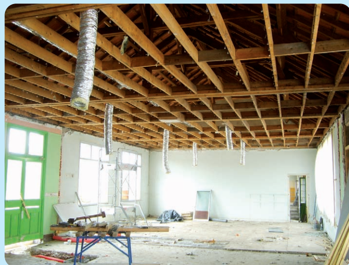
Chantier école Emile Guillaumin
