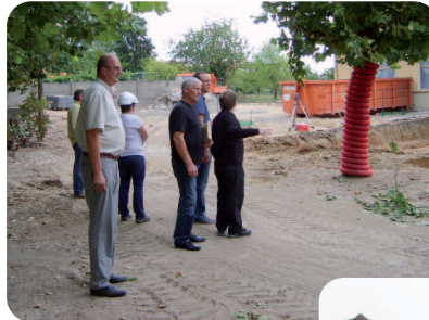
Henri Malavaud lors d'une réunion de chantier
