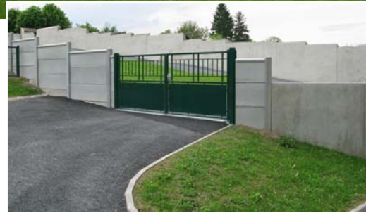
Aménagement du cimetière
