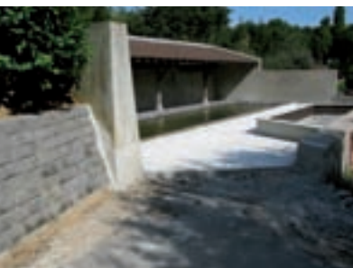
Rénovation du lavoir
