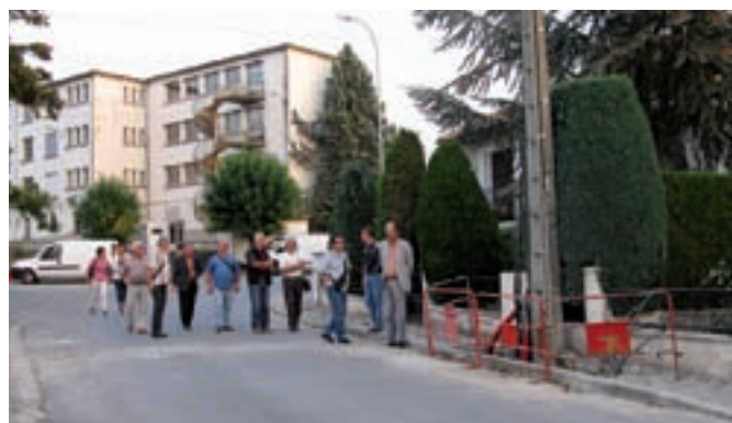
Rue de la Verne, enfouissement des lignes.
