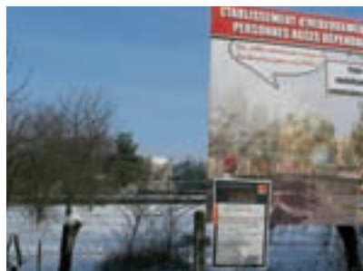
Mur de clôture de l'EHPAD, premiers travaux.
