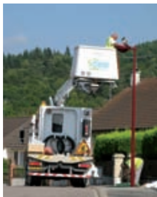
Éclairage public, changement des candélabres, rue du Peu Renard, Germinal, quartier du Gréau et de la Mairie ; un pas de plus vers les économies d'énergie
