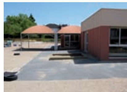
Construction d'un préau à l'école maternelle Paul ELUARD, un plus pour le confort des enfants et de la communauté enseignante.
