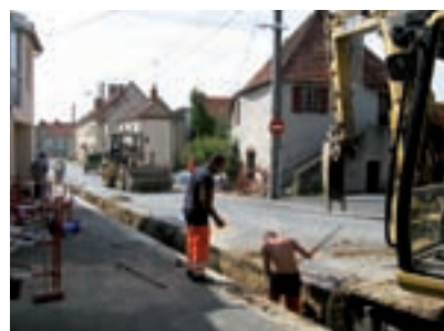
Travaux de renforcement du réseau d'eau potable, rue Joseph Besson.
