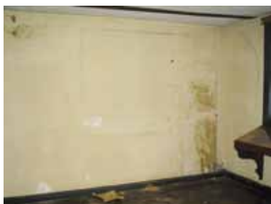
Salle archéologique, état du mur
