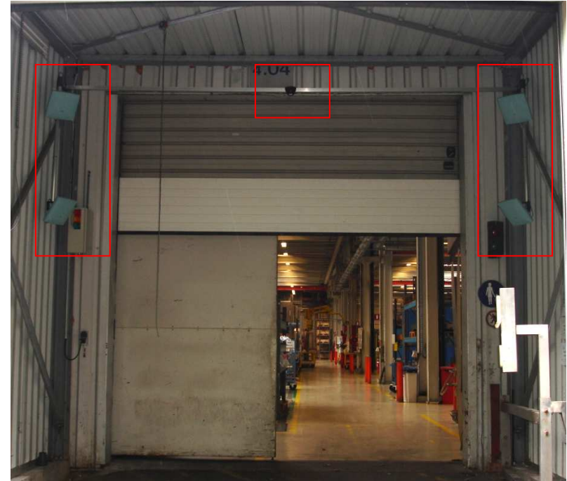
Antenna Siemens SIMATIC RF660A
