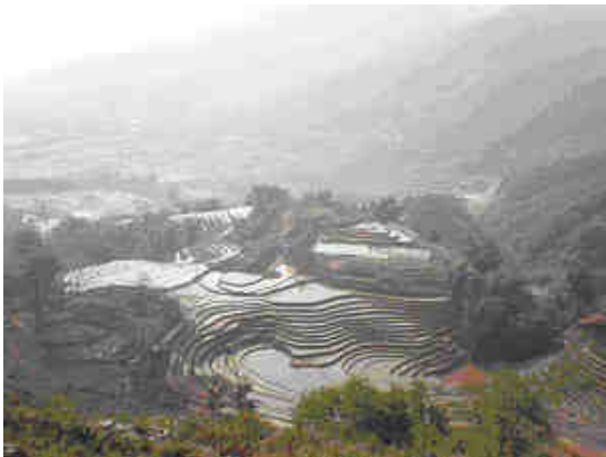
Les rivières en escalier
