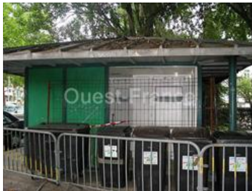
Les toilettes du parking du Britais en centre-ville sont en dérangement depuis trois semaines. « On attend une pièce pour les réparer », indique un agent municipal.
