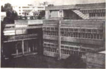
Vue sur les salles de T.D. et les ateliers
