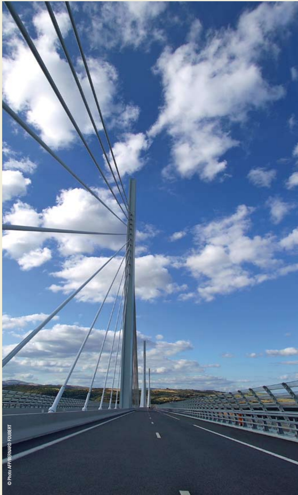
Le viaduc de Millau, pont autoroutier à haubans franchissant la vallée du Tarn, qui assure la continuité des autoroutes A75 et A71 entre Paris et Béziers. Cet ouvrage, achevé en 2004, détient quatre records du monde : la pile, la flèche et le tablier routier les plus hauts du monde et le tablier suspendu par haubanage le plus long.
