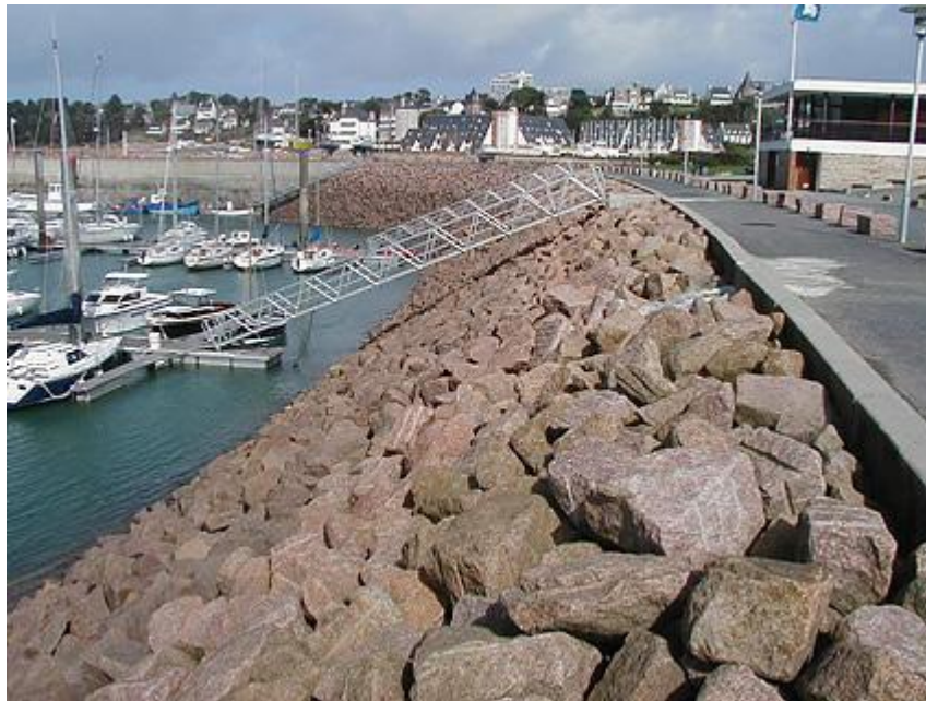
Enrochement au port de Trozoul
