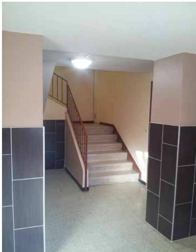
Mise en place de faïences murales dans les halls d'entrée Résidence Les Estourans - Le Thor
