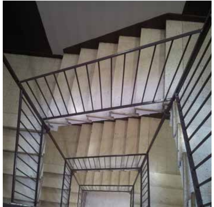
Mise en peinture complète de la cage d'escalier Résidence Saint-Martin - Cavaillon
