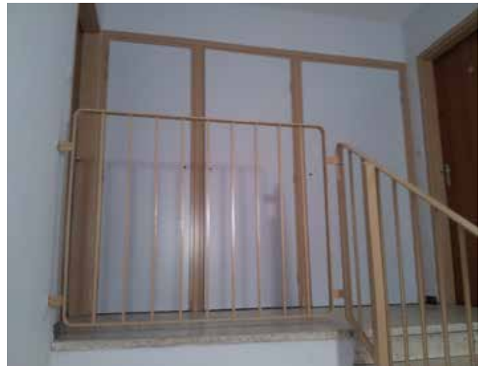
Peinture des menuiseries et serrureries Résidence La Resclauso - Bollène
