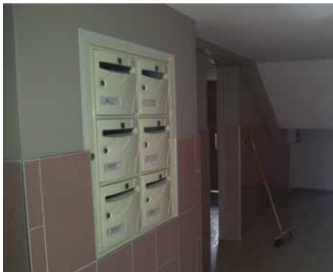
Encoffrement des boîtes aux lettres Résidence Les Hespérides - Orange
