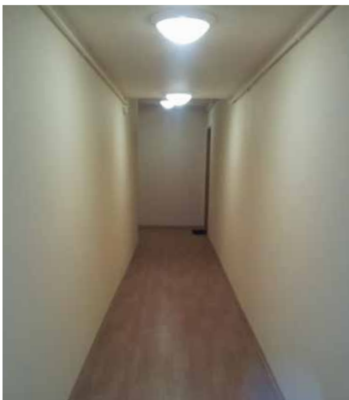
Éclairage à LED avec détection de présence incorporée Résidence Les Agates - Montfavet
