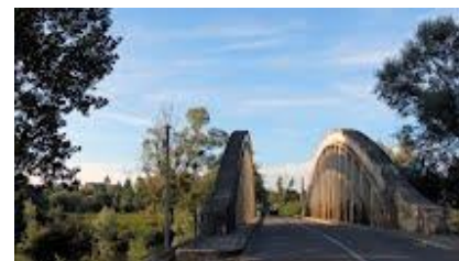
Pont sur la Seille à Branges
