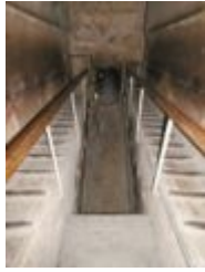
Embranchement, vue de la grande galerie vers les couloir ascendant
