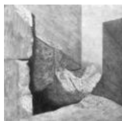
Accès au tunnel (1910)
