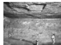
Intérieur de la chambre souterraine
