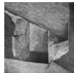
Accès au tunnel (1910)
