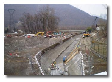
La centrale est arrêtée pendant 10 semaines pour permettre l'installation de la vanne d'entrée du bassin à construire (*travaux en cours*), puis ce sera pendant 1 an la construction du bassin.
