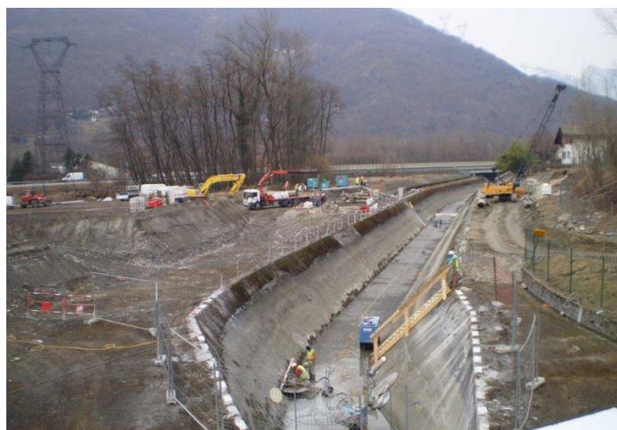
La centrale est arrêtée pendant 10 semaines pour permettre l'installation de la vanne d'entrée du bassin à construire (*travaux en cours*), puis ce sera pendant 1 an la construction du bassin.
