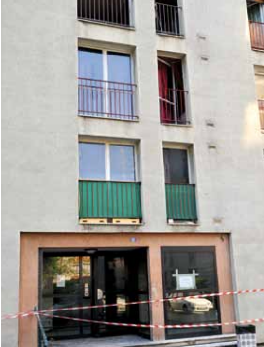
L'immeuble 12 rue des Aulnes.
