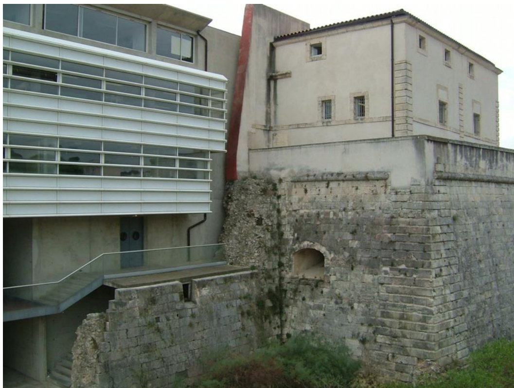
Fig. 2. Fort Vauban de Nîmes (Face nord : la bibliothèque et le bastion nord-ouest). (Crédit A. Herland)
