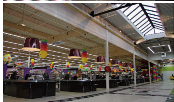
À l'Intermarché Stadium de Beaufort : omniprésence du bois lamellé, en intérieur comme en extérieur, avec une structure laissée apparente qui a, entre autre, permis l'intégration d'une verrière en toiture.
