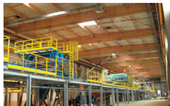
Plateforme de stockage avec structure en bois lamellé, réalisée pour Isover. Un bâtiment qui répond avant l'heure aux exigences réglementaires.
