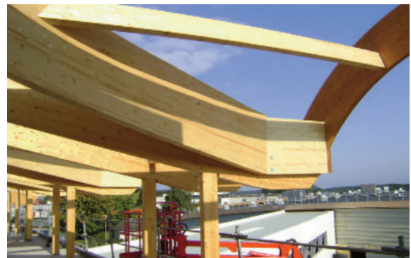
Structure en bois lamellé pour ce bâtiment logistique "expédition et transtockeur" des Grands Chais de France, de 11575 m 2 à Petersbach.
