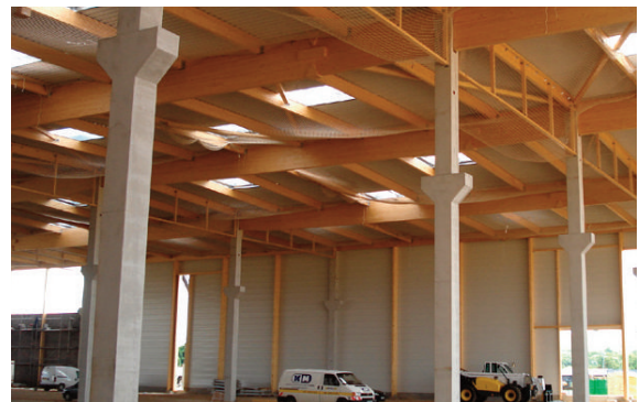
18 500 m 2 de bâtiments achevés en 2008 pour Nexity Geprim. La structure, en lamellé, compte des poutres dépassant 25 mètres de portée.
