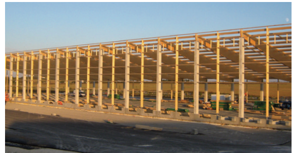
Plateforme logistique réalisée pour Alloin à Bourges. La structure, en lamellé collé, permet au maître d'ouvrage de répondre aux futures exigences du décret.
