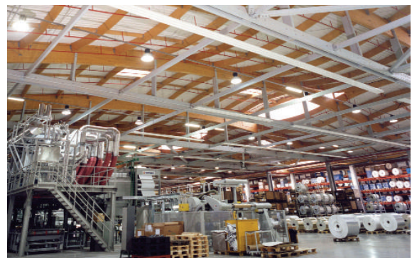
La Société Alsacienne d'Aluminium a choisi pour son bâtiment industriel de 12493 m 2 le bois lamellé en structure.
