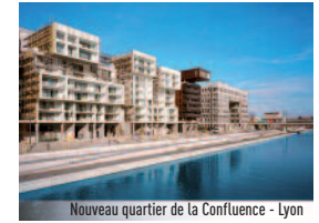
Nouveau quartier de la Confluence - Lyon
