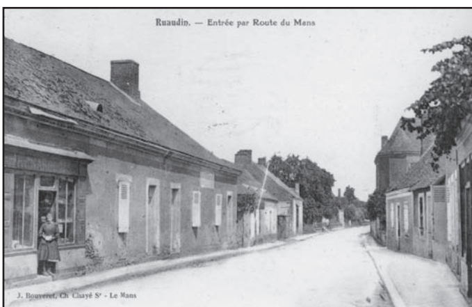
Les premières maisons du village sur la route du Mans
