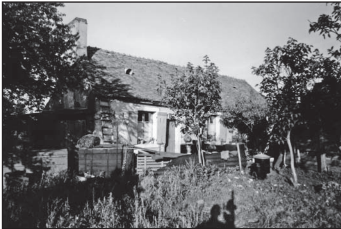
Ancienne ferme des Quartiers Sud (1967) Son emplacement précis n'est pas connu.
