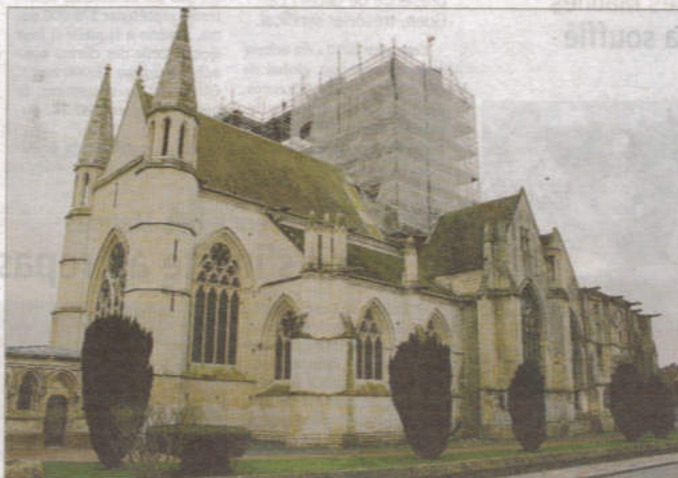
La seconde tranche des travaux de restauration de l'église Notre-Dame aurait pu ne pas voir le jour... Et pourtant...
