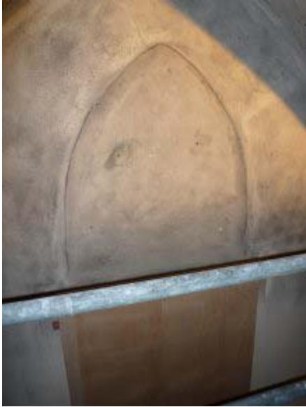
7. Chapelle du Sacré-Cœur après l'incendie de juillet 2009 Emplacement d'un vitrail représentant la Rédemption occulté par du ciment Le vitrail se trouve encore conservé dessous. Photo prise le 21 mai 2010 après étude et début de restauration
