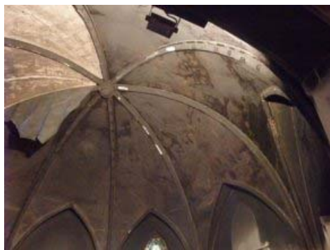
Chapelle du Sacré-Cœur après l'incendie de juillet 2009 Photo prise le 10 août 2009
