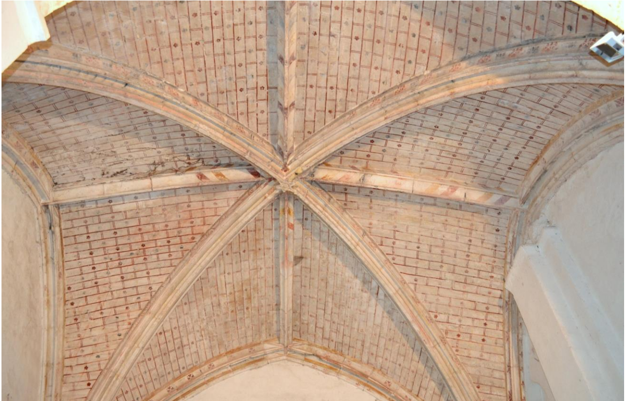
Vue du décor en place sur la voûte
