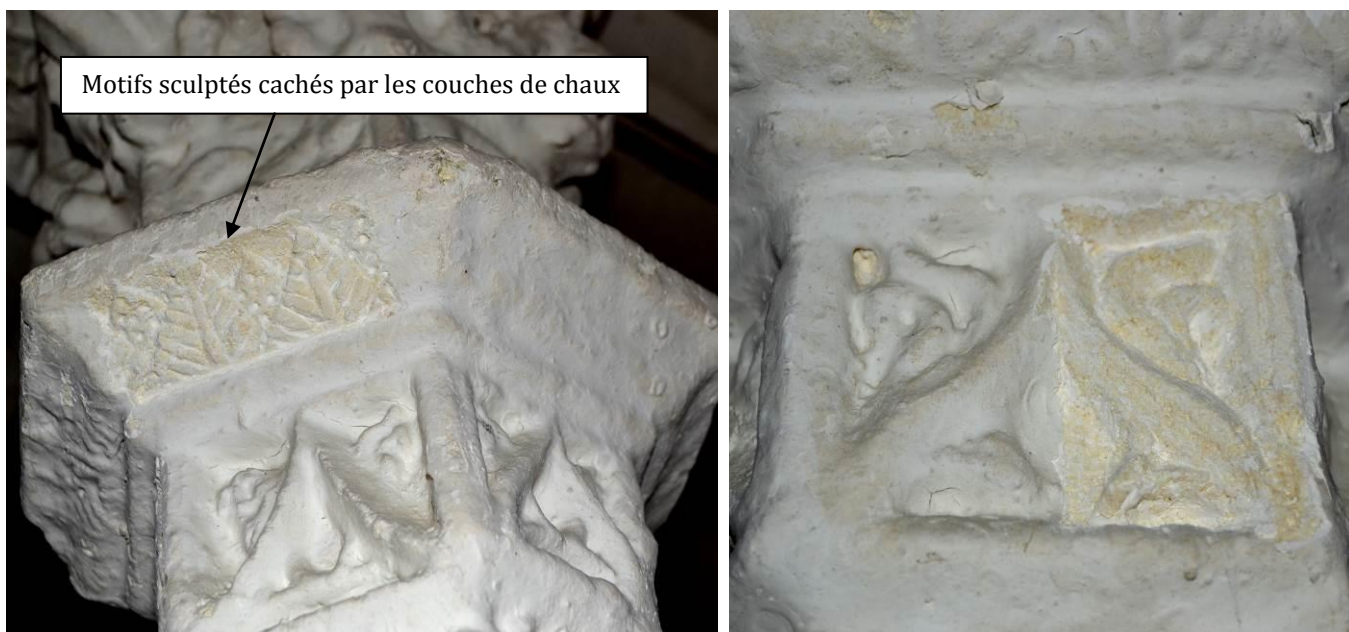
Vue des dégagements réalisés sur la clé de voûte
