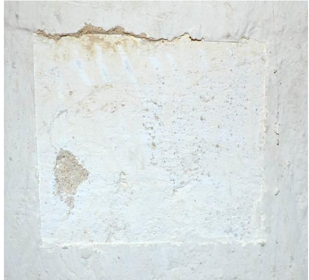
Vue du sondage n°45 : Badigeon contemporain de la litre
