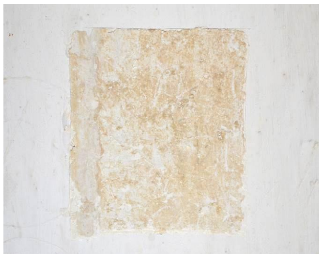
Vue du sondage n°59 : pierre calcaire
