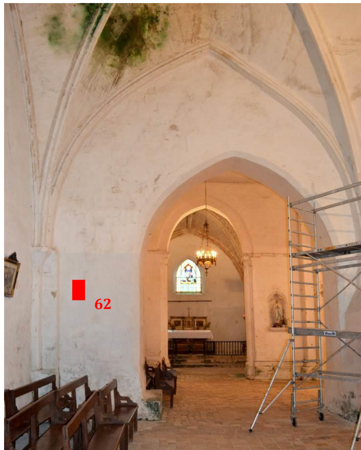
Localisation exacte du sondage
