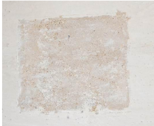
Vue du sondage n°52
