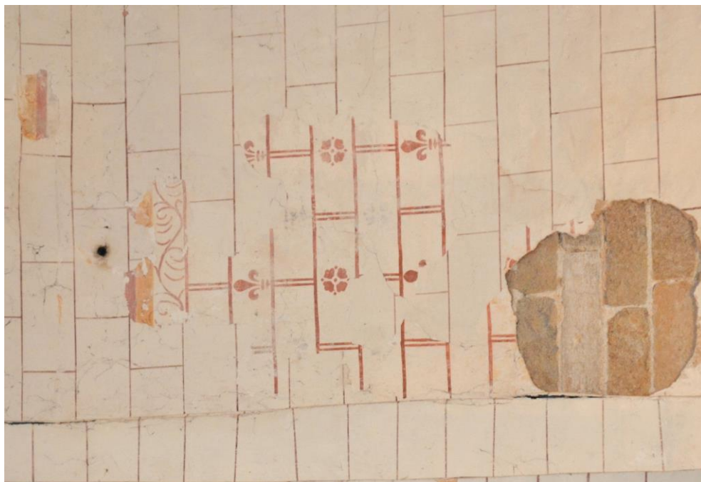
Vue du sondage n°112
