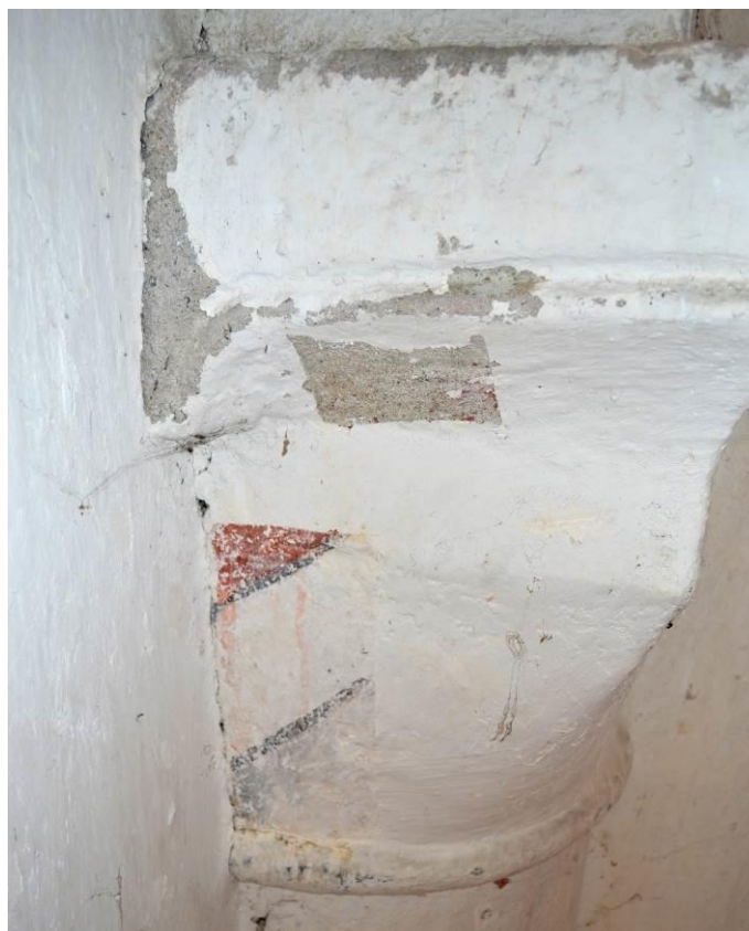
Vue du sondage n°7
