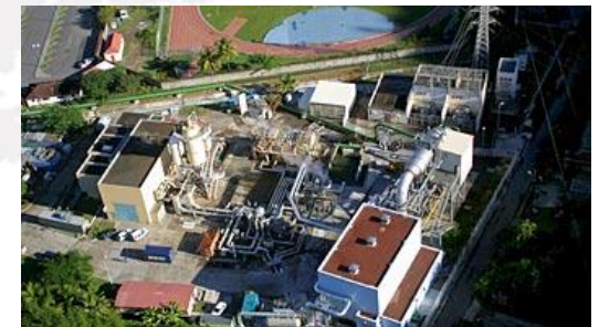
Géothermie « haute énergie » Centrale de Bouillante (Guadeloupe)
