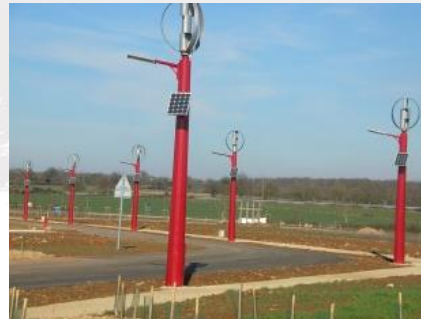
Exemple de mâts d'éclairage public intégrant éoliennes et panneaux photovoltaïques
