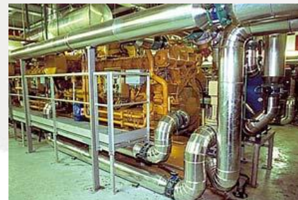
Géothermie « basse énergie » La Courneuve (1993)
