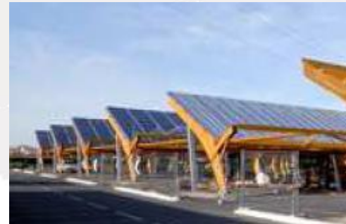
Exemple de panneaux photovoltaïques intégrés en ombrières de parking
