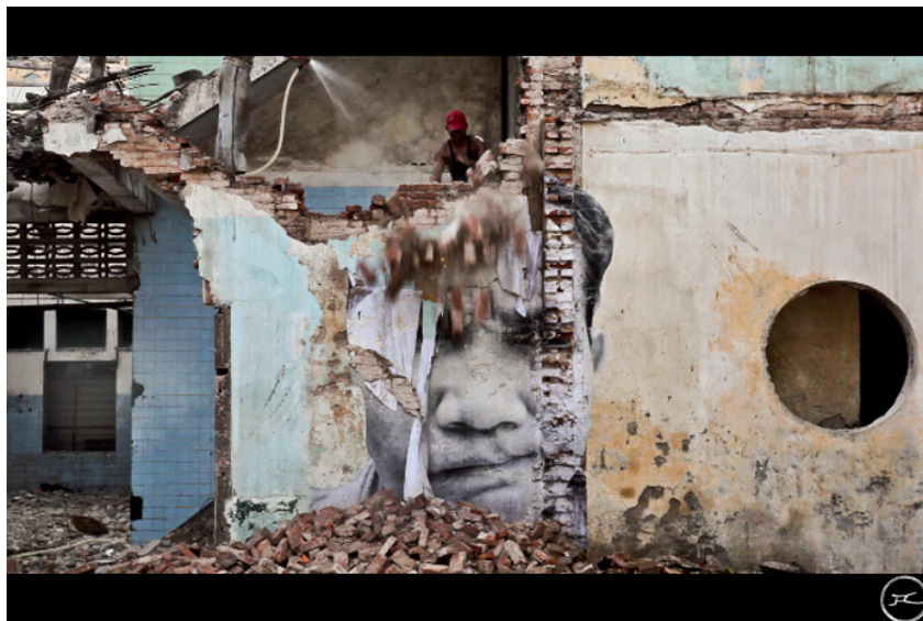
Cambodge, Phnom Penh, Démolition , Mars 2009.
