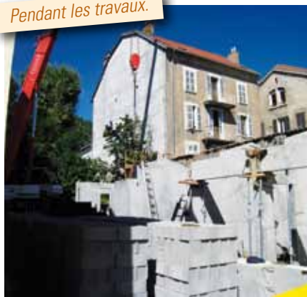
Pendant les travaux.
