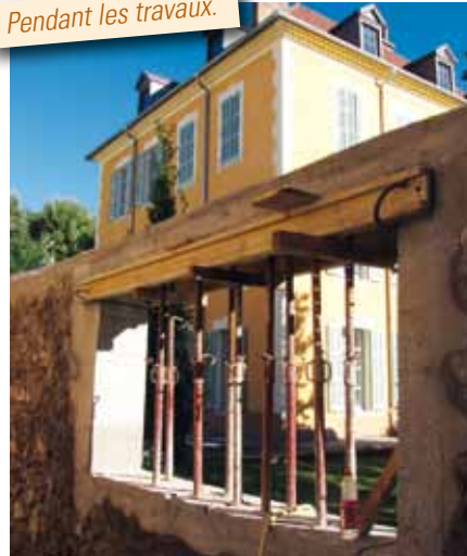
Pendant les travaux.
