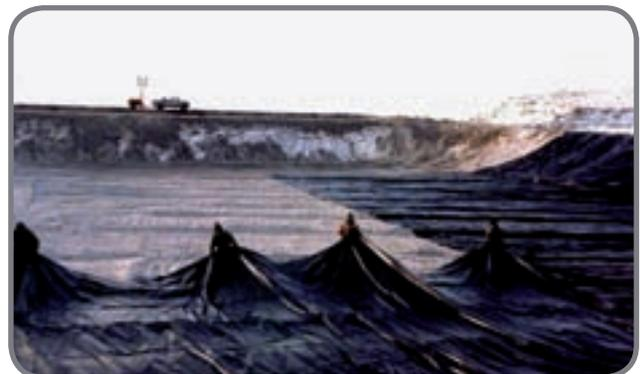
Exemple d'installation d'une géomembrane de confinement
